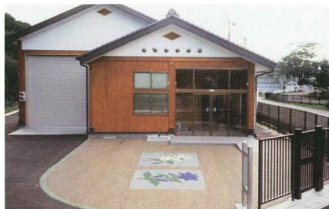
▲カラー樹脂舗装(遠野町)
