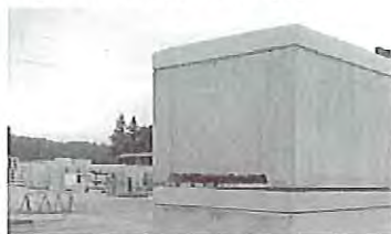
写真4. 重ねて運搬する様子
